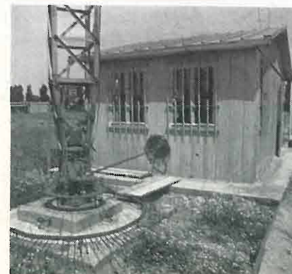
Base dell'antenna VLF/LF e cabina di sintonia, erette dall'I.E.N. a Torino (zona Mirafiori) per trasmissioni di segnali di tempo di alta precisione a banda stretta; si notino i conduttori a raggera della presa di terra che in totale sono 240 (articolo a pag. 3).
