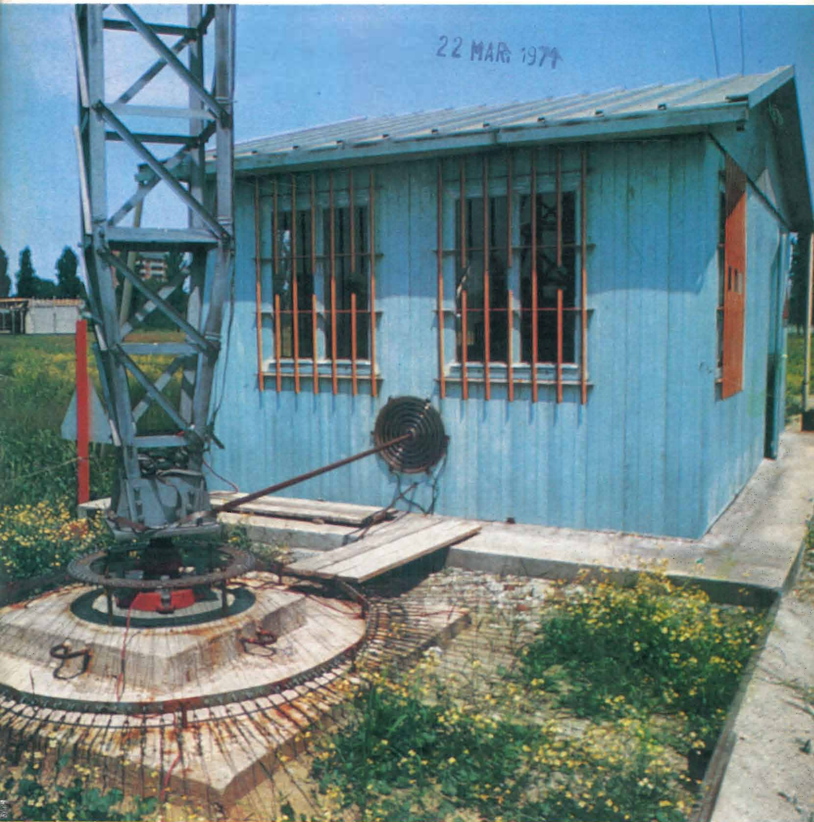
Antenna VLF/LF eretta dall'I.E.N. per segnali di tempo di alta precisione a banda stretta (art. a pag. 3).
