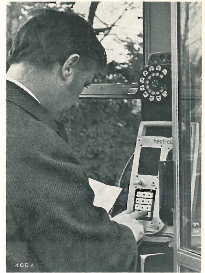
Fig. 3. — Trasmissione di dati da un posto telefonico pubblico.
